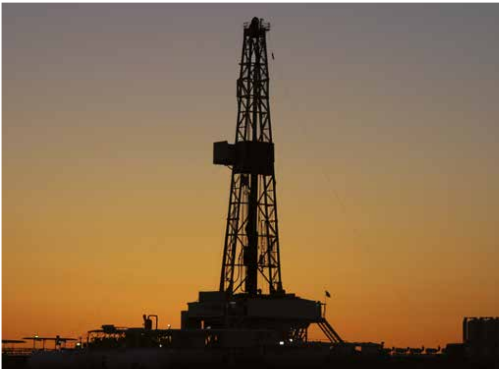
Tours de forage pétrolier (également applications à basse température)
